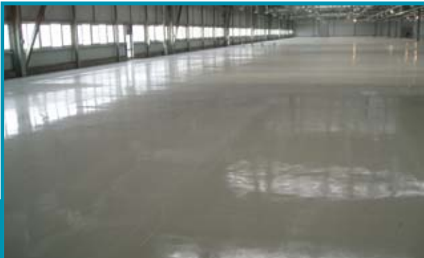
Производственный цех с бетоном ROMEX®-BETON и заключительным покрытием ROMPOX® 1005 • Production hall with ROMEX® CONCRETE and subsequent ROMPOX® 1005 coating • Produktionshalle mit ROMEX®-BETON und anschließender ROMPOX® 1005 Beschichtung
